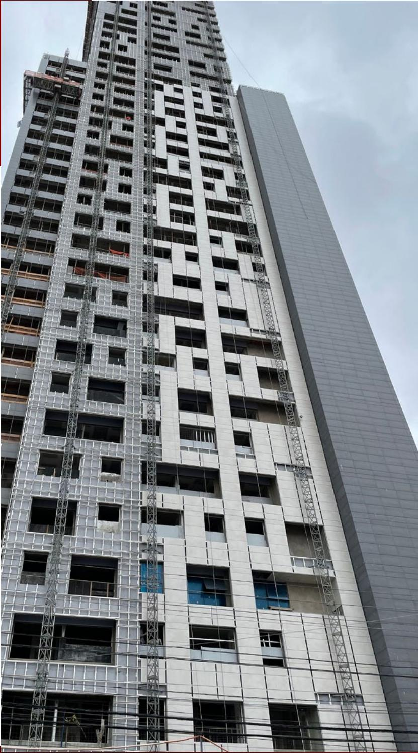
La utilización de un sistema con perfilaría reticulada permite adaptar la estructura y las necesidades de rendimiento requeridas según el estudio de túnel de viento. Además de disipar las tensiones que la estructura del propio edificio genera, como torsiones y movimientos. Esto es de extrema importancia cuando hablamos de fachadas ventiladas en rascacielos, brindando la estética deseada junto con la máxima seguridad.
